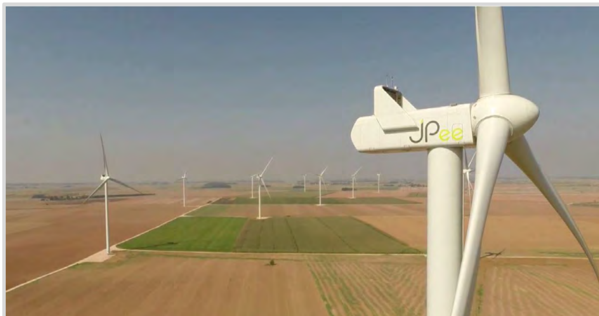
PHOTO 1 - PHOTOGRAPHIE DU PARC EOLIEN DU MOULIN D'EMANVILLE
